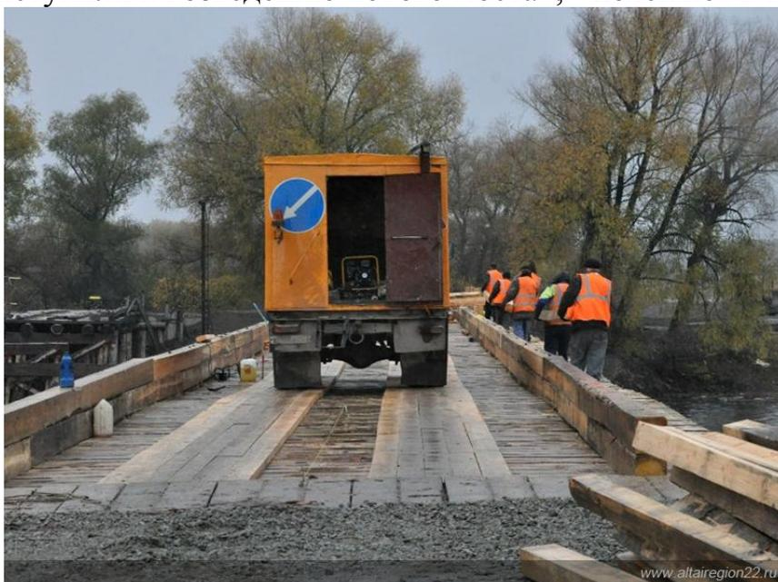
«Сейчас мы находимся на завершающей стадии строительства – ведется устройство настила, перильных и колесоотбойных ограждений, а также подходов к мосту. Мост однополосный, полностью деревянный, выполнен из сосны, весь материал пропитан специальным составом для увеличения срока эксплуатации. По проекту это сооружение прочнее того, что было смыто наводнением, и прослужит не менее 20 лет», - рассказывает начальник подрядной организации Троицкого ДРСУ Алексей Чегодаев.
